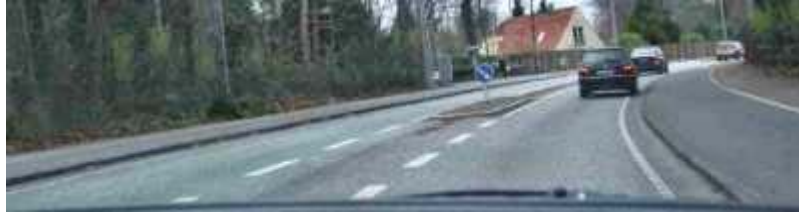
Mynd 2: Við at seta strikurnar inni á vegnum, tykist vegurinn smálri, enn hann í veruleikanum er. Strikurnar til hægri larma, tá ið koyrt verður á tær.
